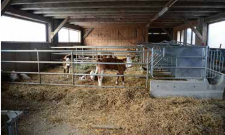
Einbau Tiefstreuall im Altgebäude mit erhöhten Einzelfressständen, der Liegebereich ist aber nicht vertieft errichtet.
