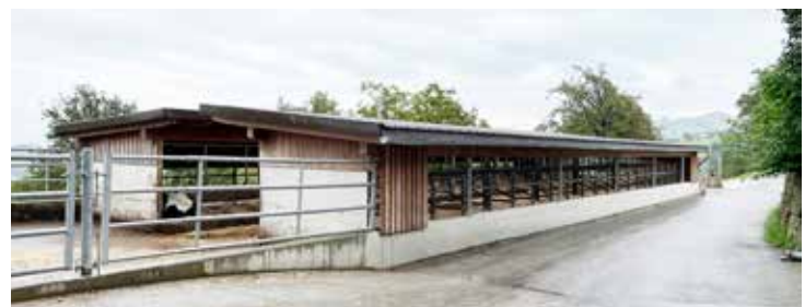
Das obere Bild wirft einen Blick von der Weide am Hang oberhalb der Hofzufahrt auf den Neubau – im Hintergrund der Altbestand. Im unteren Bild blickt man vom Altbestand Richtung Hofzufahrt. Fotos: Paula Pöchlauer-Kozel/LK NÖ
