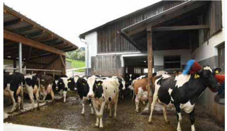
Der Auslauf ist vor dem Stall mit mobiler Entmistung, Außenliegeboxen und Kuhbürste. Der Auslauf ist zugleich Warteplatz. Fotos: Josef Rechberger/LK NÖ
