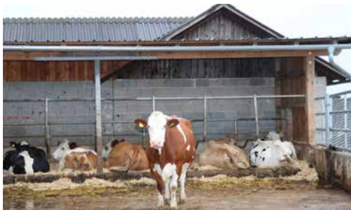
Die Kuh marschiert im Auslauf in Richtung Neubau. Hinter ihr sind Außenliegeboxen an der Wand des Altbaues angebracht. Diese Liegeboxen sind so gut wie immer belegt und nach Osten offen. Foto: Paula Pöchlauser-Kozel/LK NÖ
