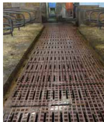
Rillen in Laufgang schneiden, bietet wieder Rutschsicherheit.
