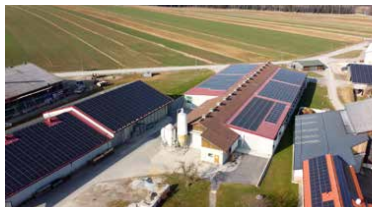
Rund 500.000 kWh Strom produziert Dietmar Hipp auf seinen Stall- und Hallendächern. Davon benötigt er 40.000 kWh für den eigenen Betrieb. Den Rest speist er ins Netz ein.
