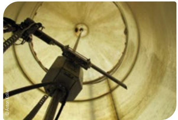
Abb. 38: Silo immer wieder komplett leeren und mit einem Spezialgerät reinigen, desinfizieren und trocknen lassen.
