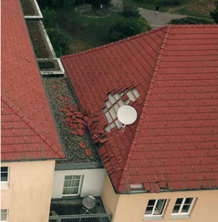
Nach Wetterereignissen wie Hagel oder Sturm kann ein Inspektionsflug mit der Drohne sehr nützlich sein, um das Schadensausmaß abzuschätzen.
