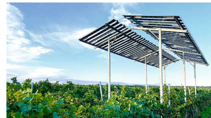
Photovoltaik im Weinberg (hier eine Pilotanlage der Energie Burgenland in Donnerskirchen) soll in Zukunft auf ein und derselben Ackerfläche Wein und Strom liefern, das hat sich im Ausland schon bewährt
